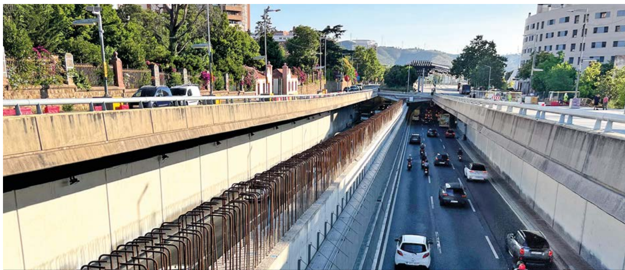
El tram entre l'institut Vall d'Herbon i l'institut Vallcarca de la Ronda es cobrirà amb una prelosa aquest estiu. Foto: M.P.S.
